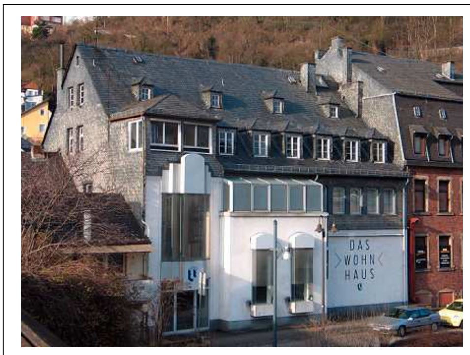
Ansicht des Gebäudes von der Bundesstraße 41 aus
